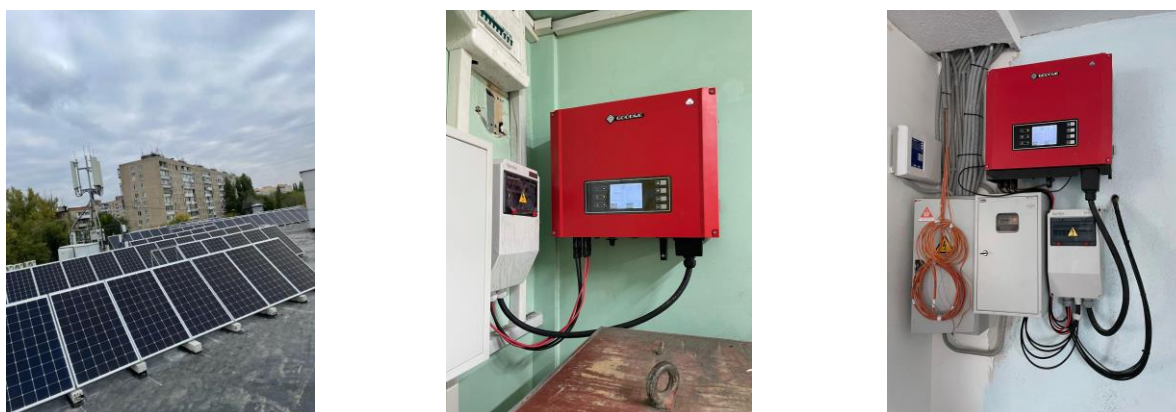
Рисунок 4 – Действующая сетевая солнечная электростанция (г. Энгельс, Саратовская область)
